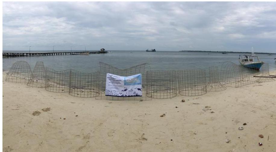
**Gambar 4.4** Rangka besi untuk terumbu buatan dan media transplantasi karang yang telah selesai dirakit dan siap untuk diletakkan di lokasi transplantasi karang (dokumentasi kegiatan, 2020)
