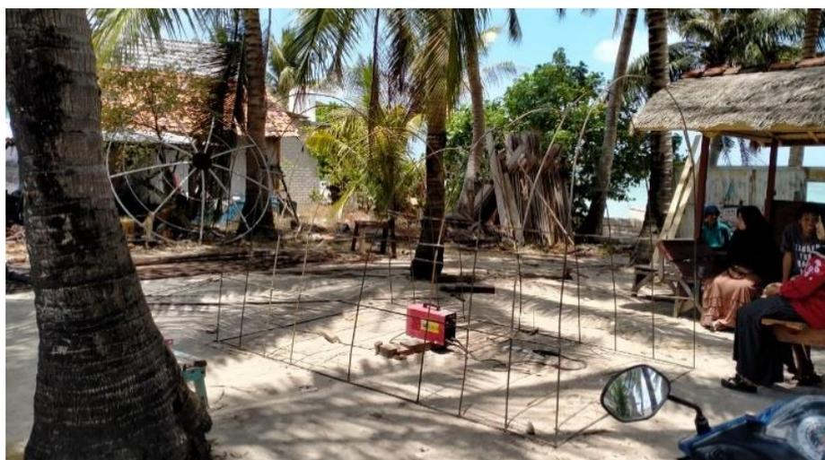
**Gambar 4.3** Proses perakitan rangka besi untuk terumbu buatan dan media transplantasi karang yang dibantu oleh warga lokal Pangerungan Besar (dokumentasi kegiatan, 2020)
