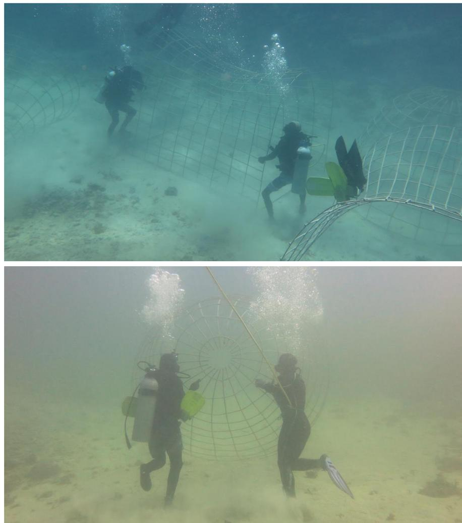
**Gambar 4.6** Peurunan ke dasar laut dan penataan posisi rangka besi untuk terumbu buatan dan media transplantasi karang (dokumentasi kegiatan, 2020)
